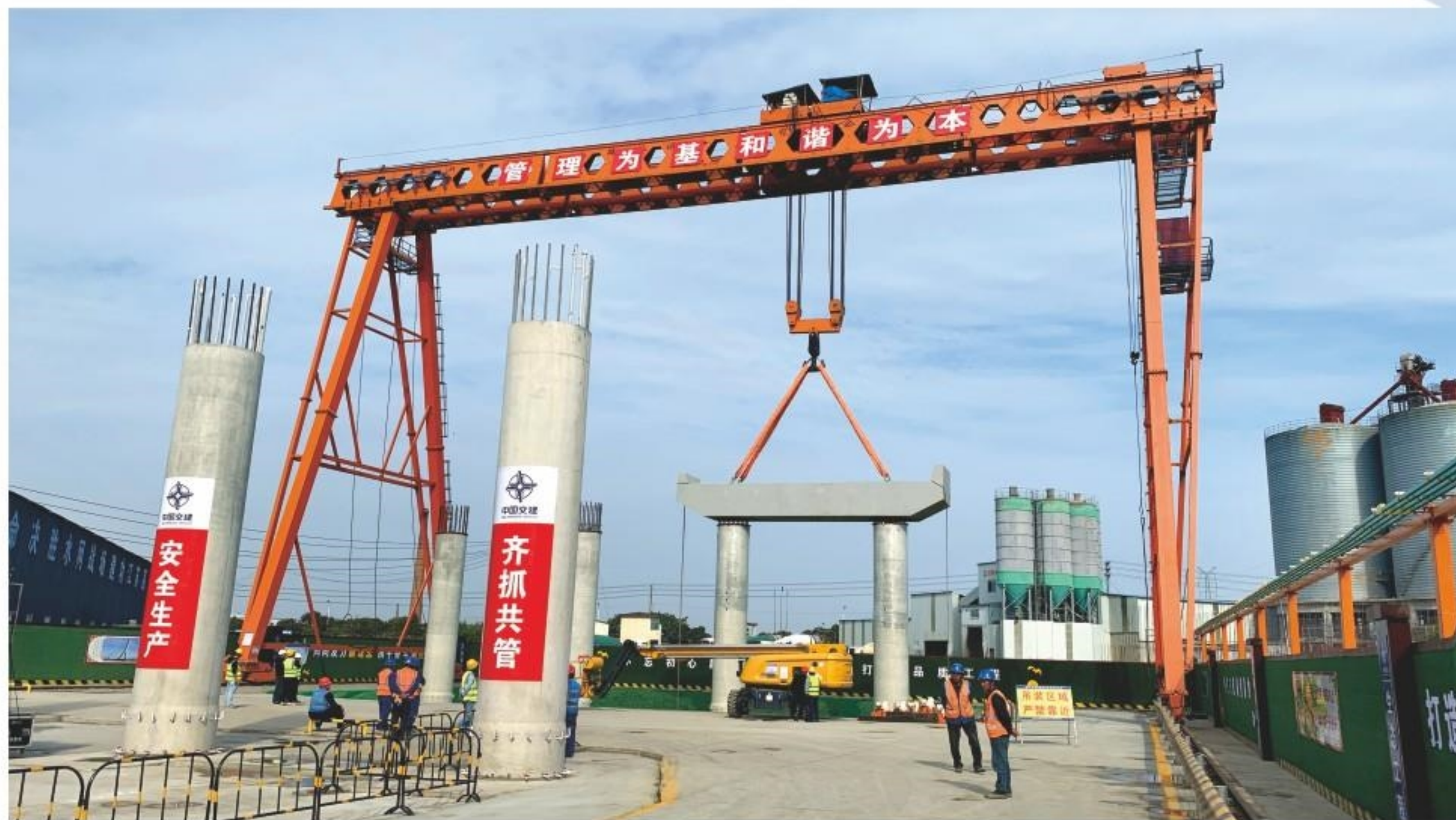
一体化提梁点预制盖梁安装
