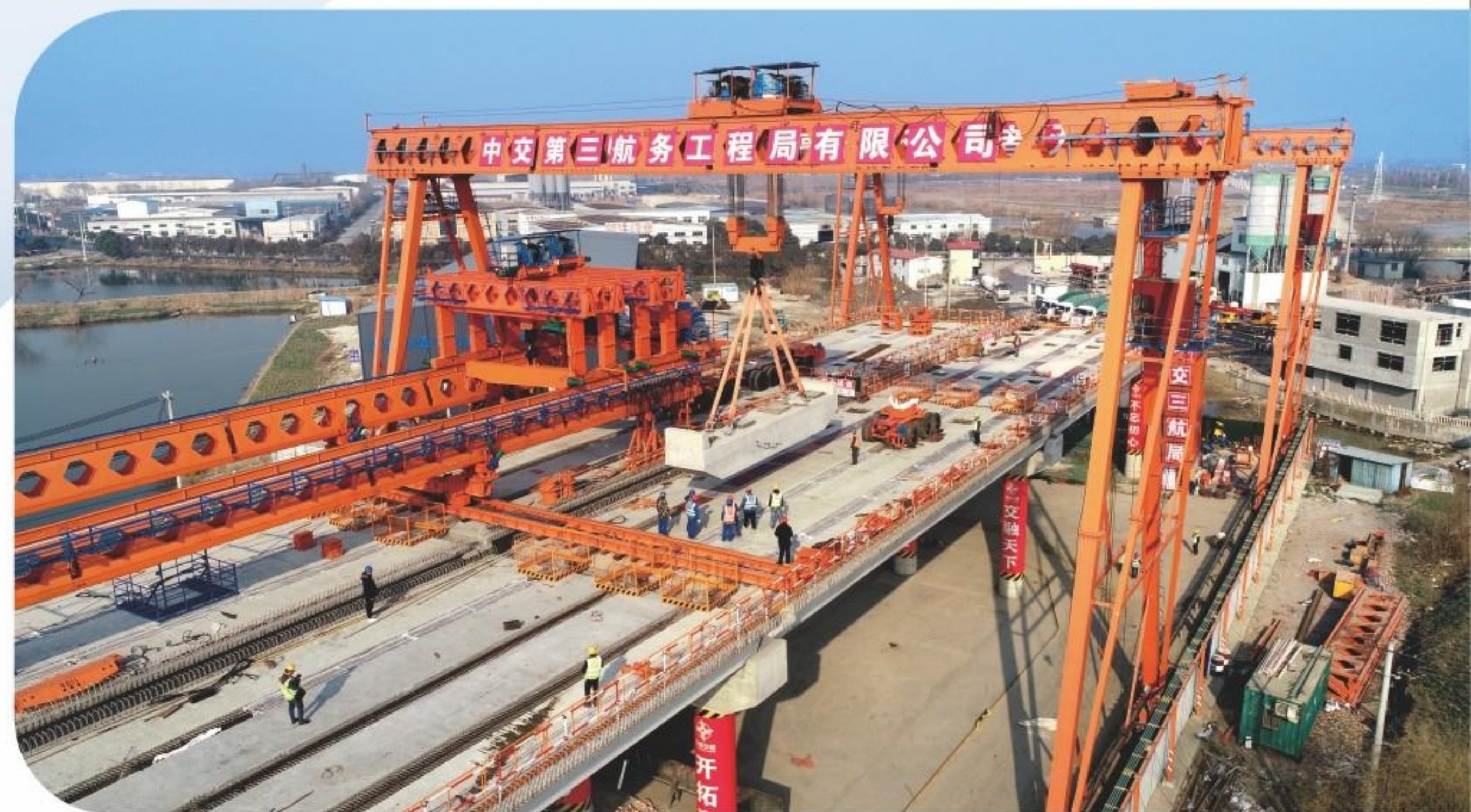
● 一体化提梁点龙门吊吊装预制盖梁
