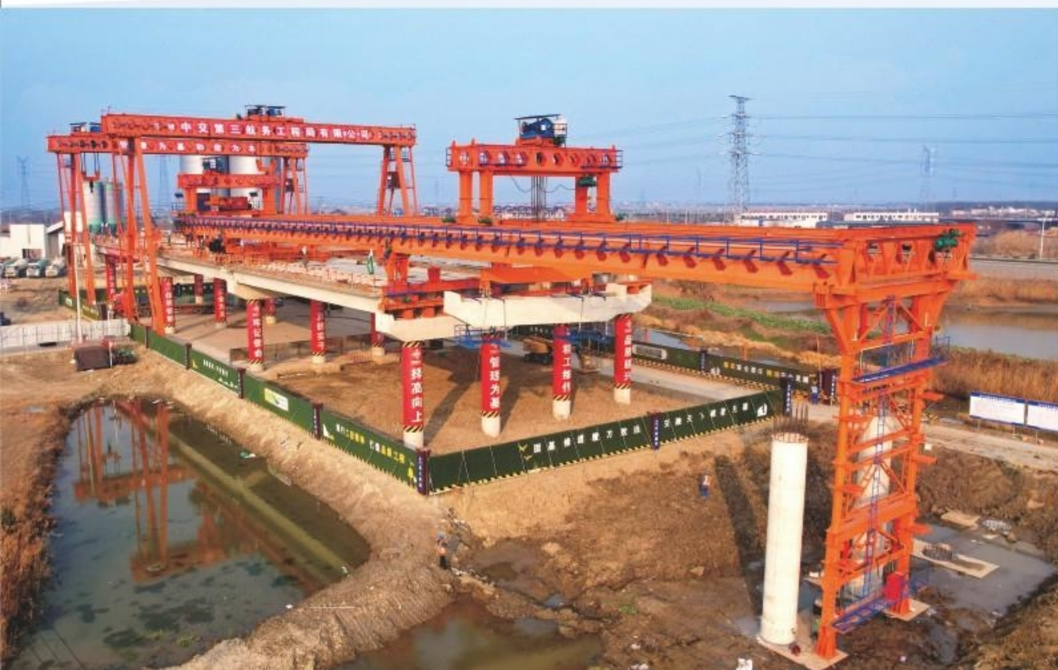
一体化提梁点实景图
