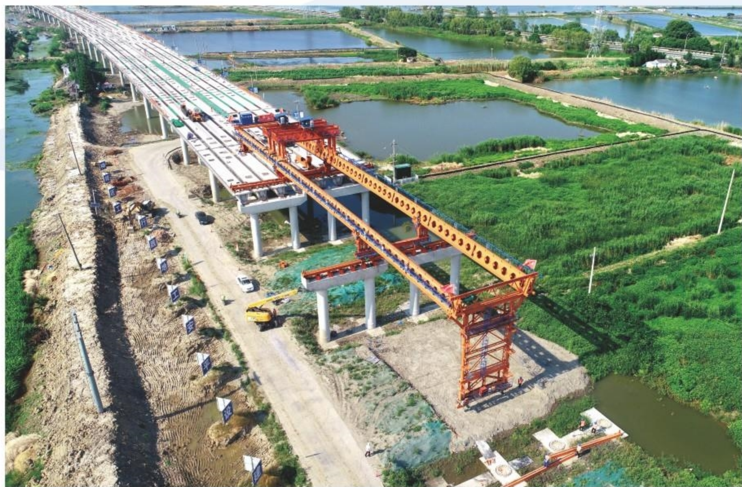
● 一体化架桥机正在过孔
