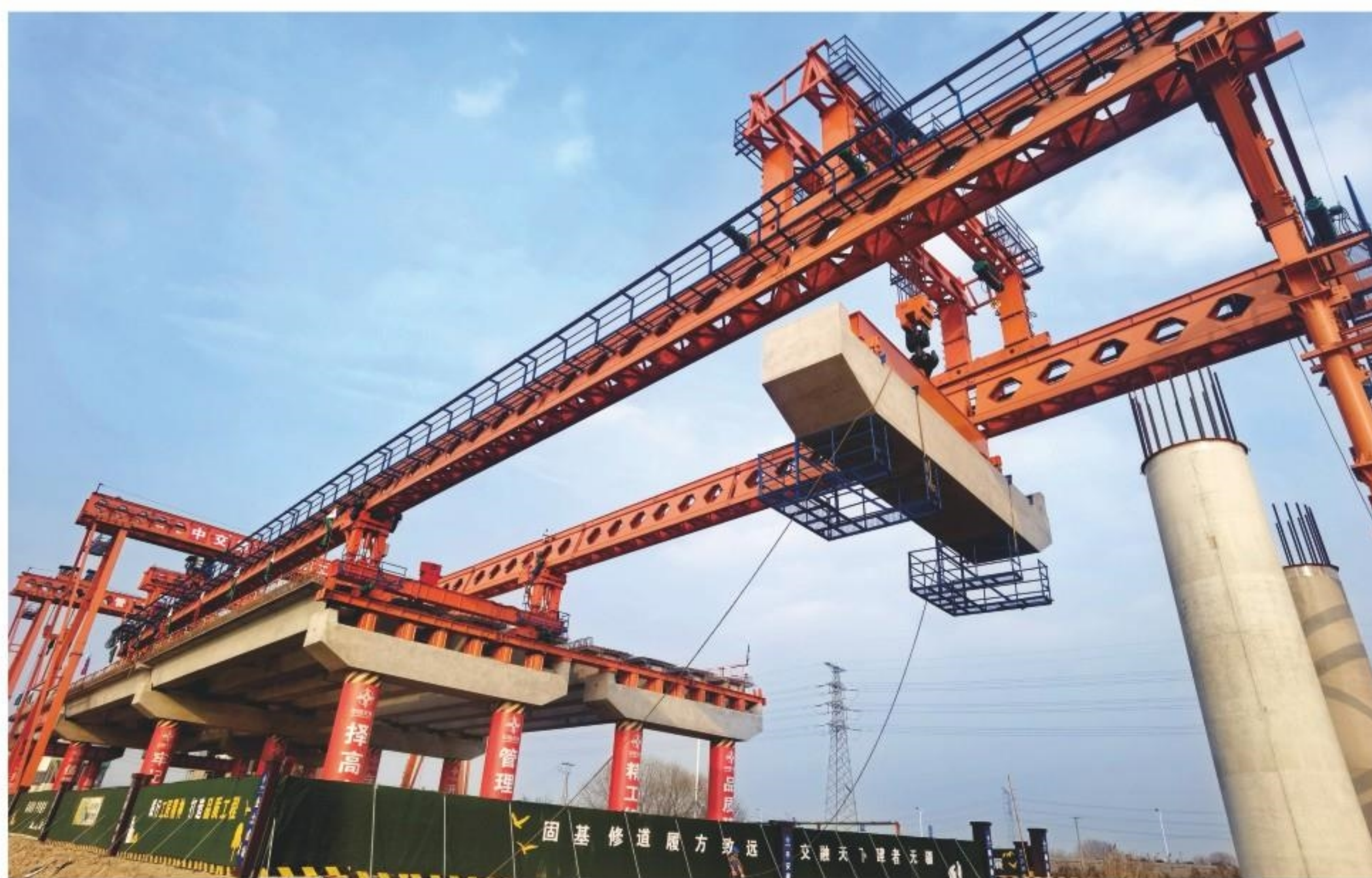
一体化架桥机安装预制盖梁
