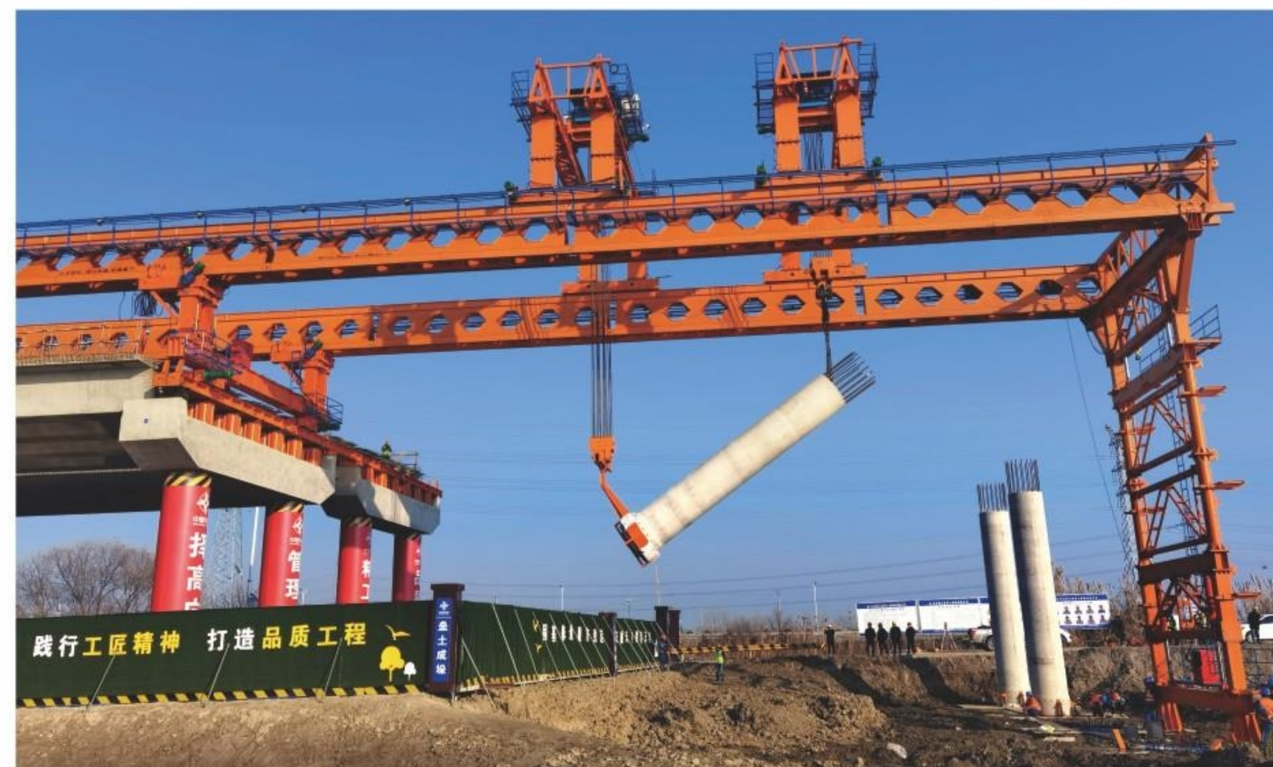
一体化架桥机空中翻转预制立柱
