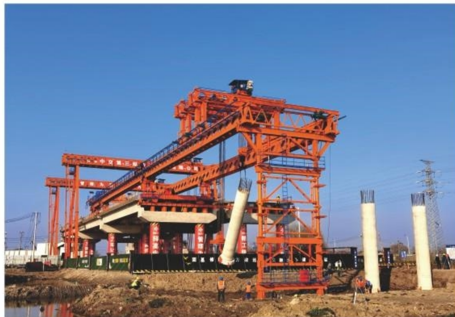
● 一体化架桥机空中翻转预制立柱
