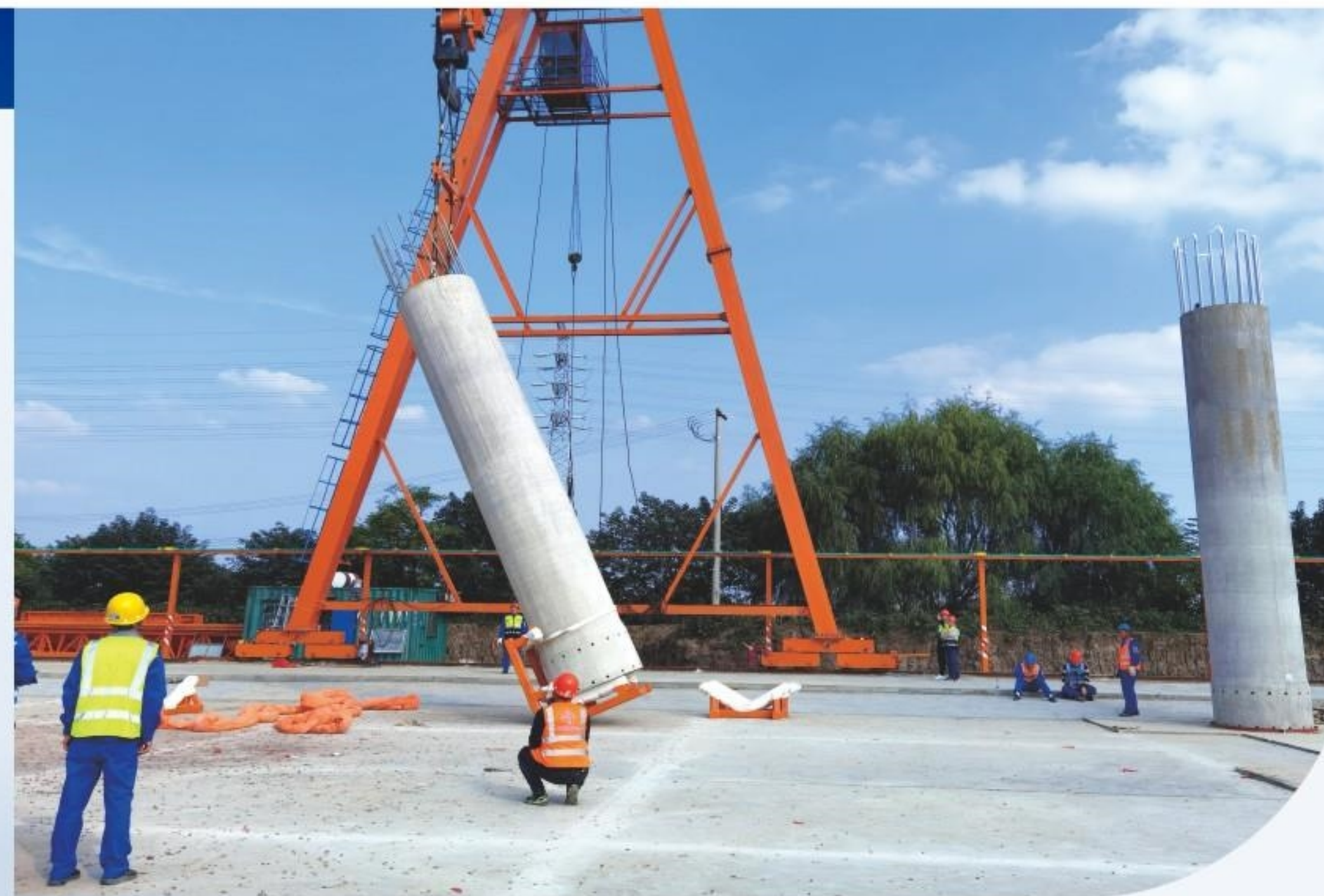
提梁龙门吊翻转立柱
