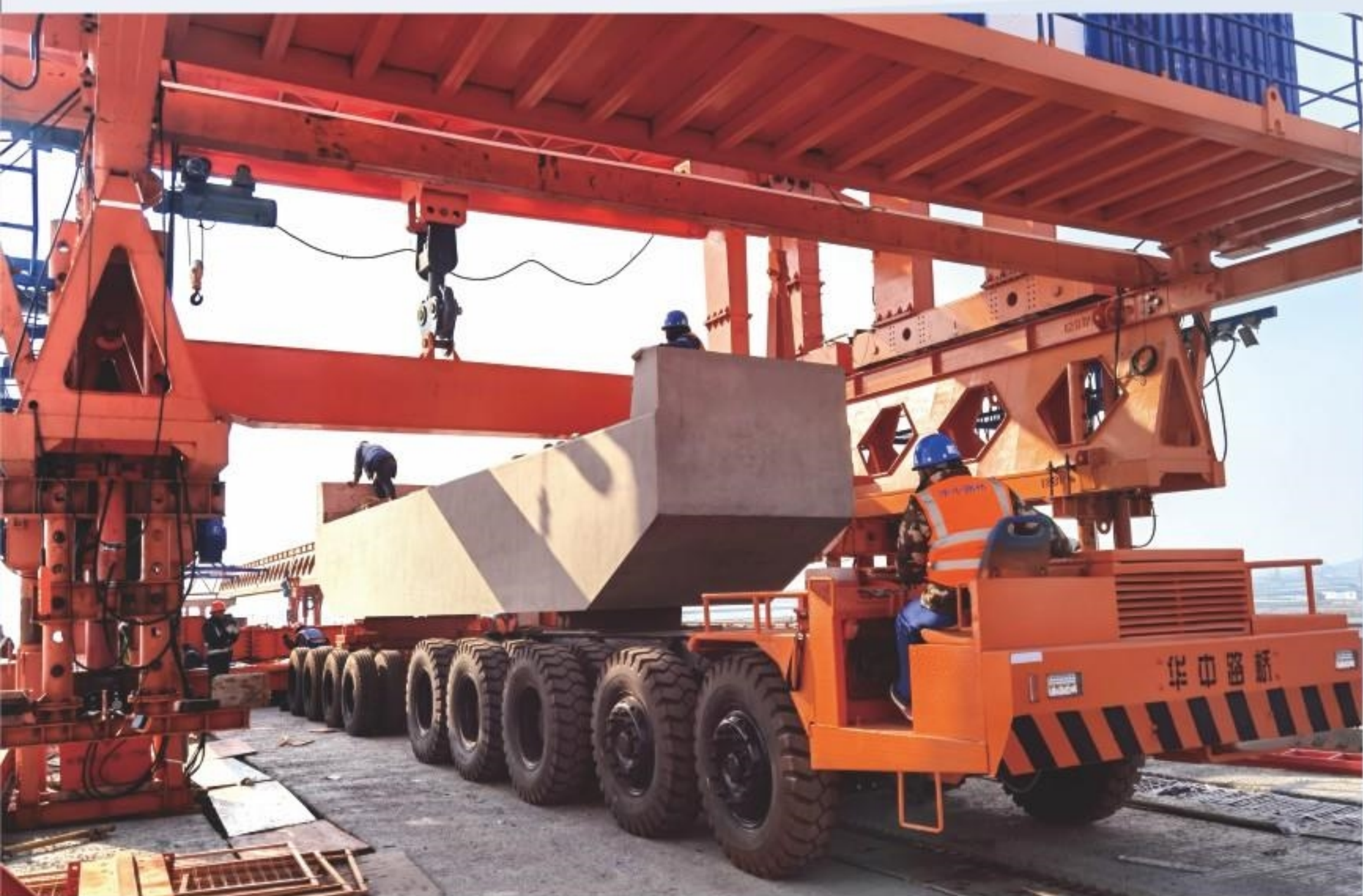
盖梁运至架桥机尾部
