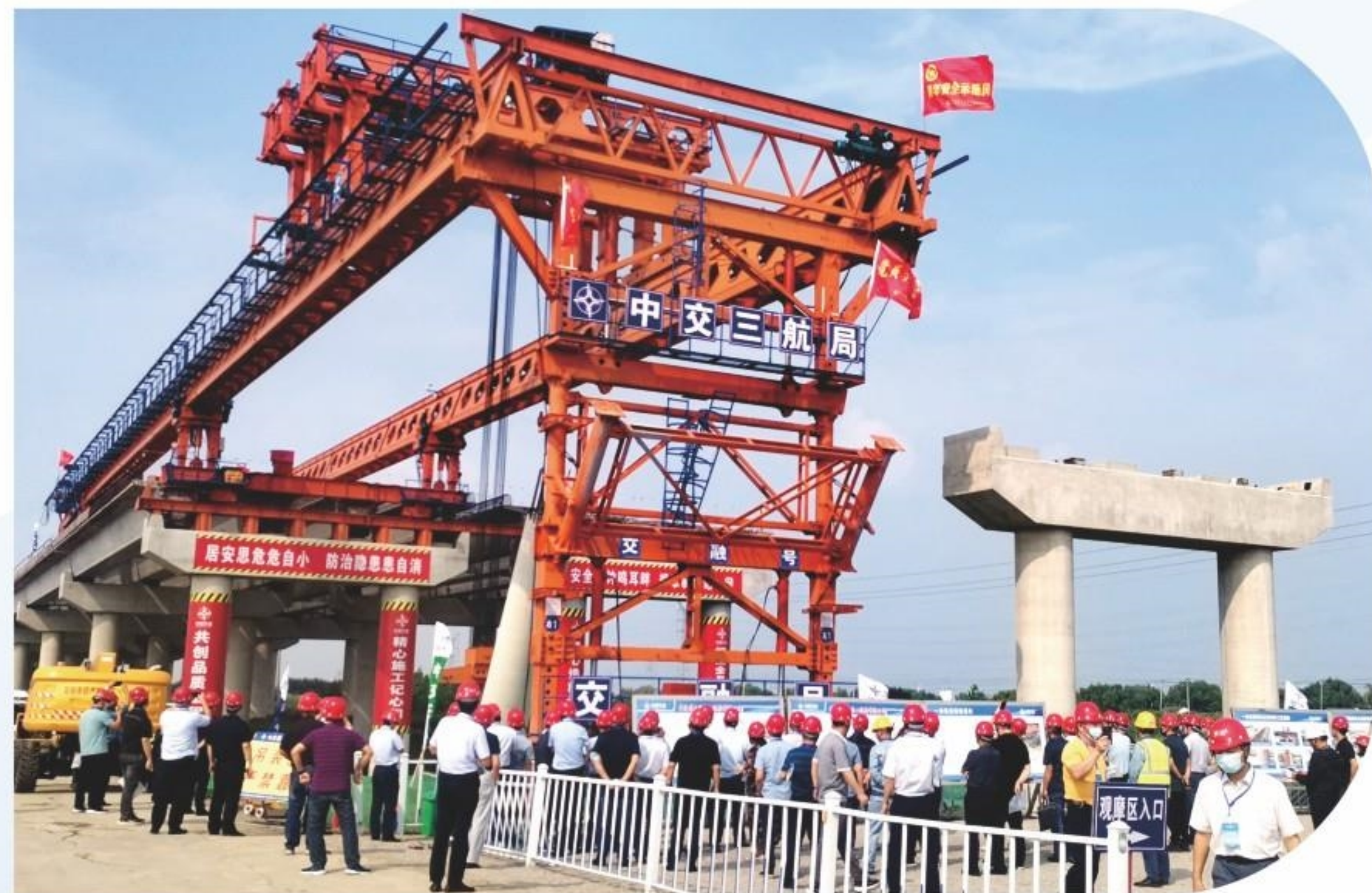
江苏省交通运输厅 领导现场观摩 一体化架桥机施工
