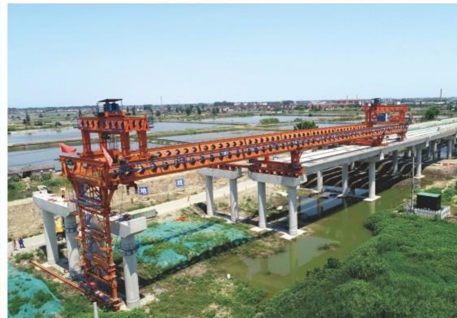
● 一体化架桥机安装预制盖梁
