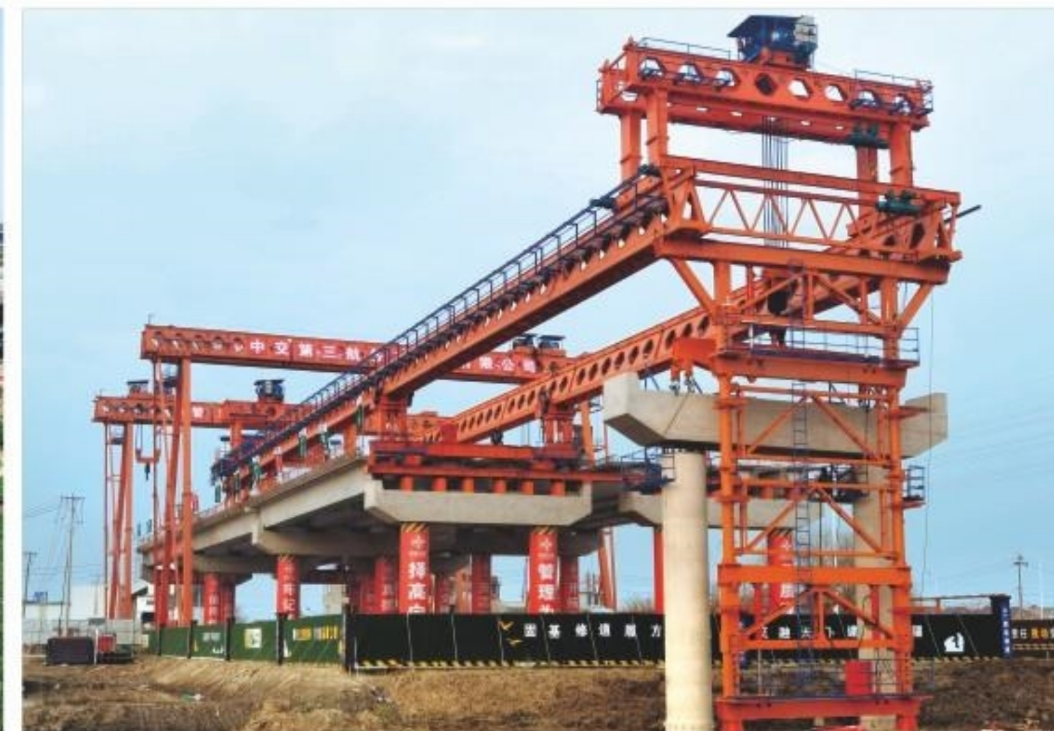
● 一体化架桥机安装预制盖梁
