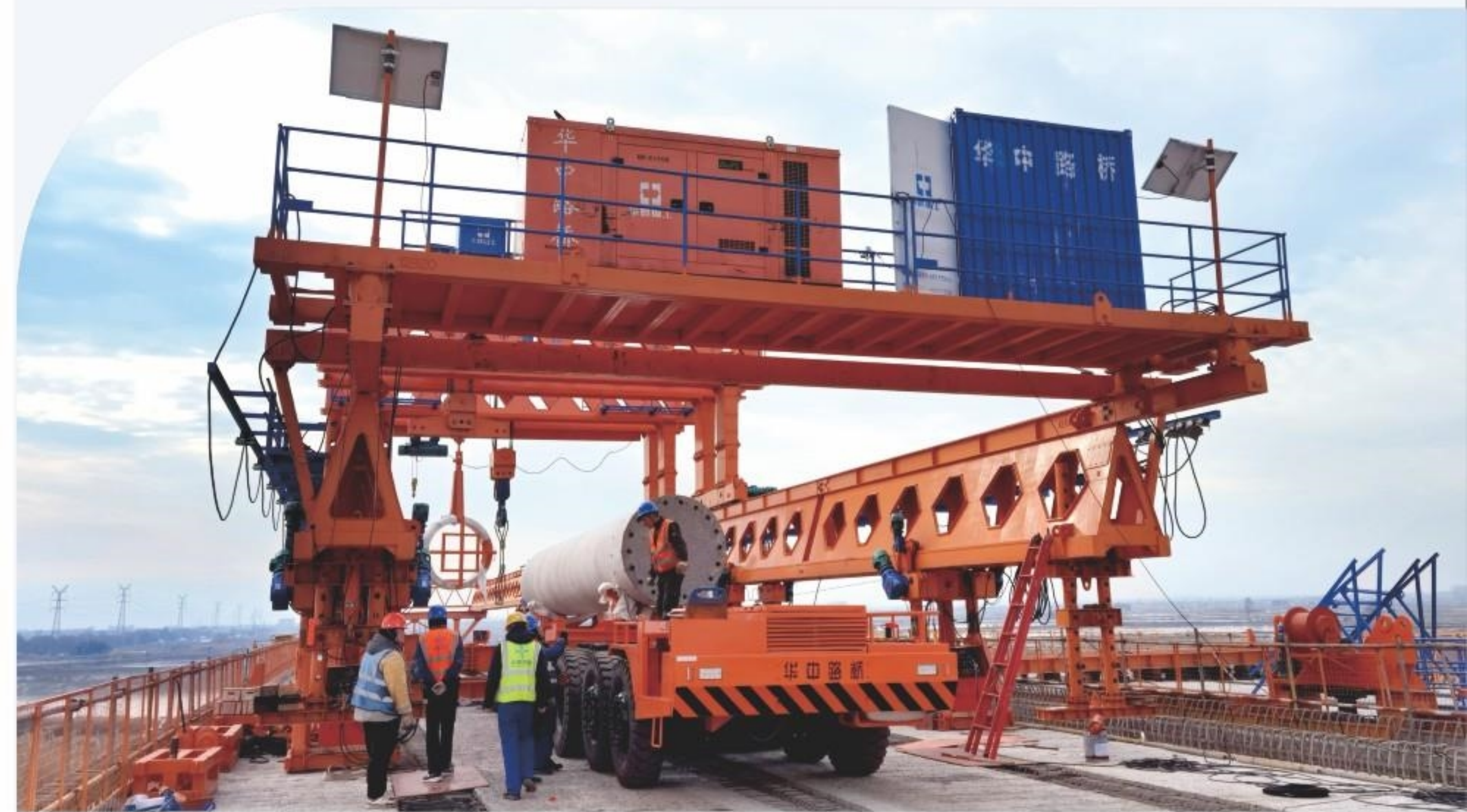
预制立柱运至架桥机尾部
