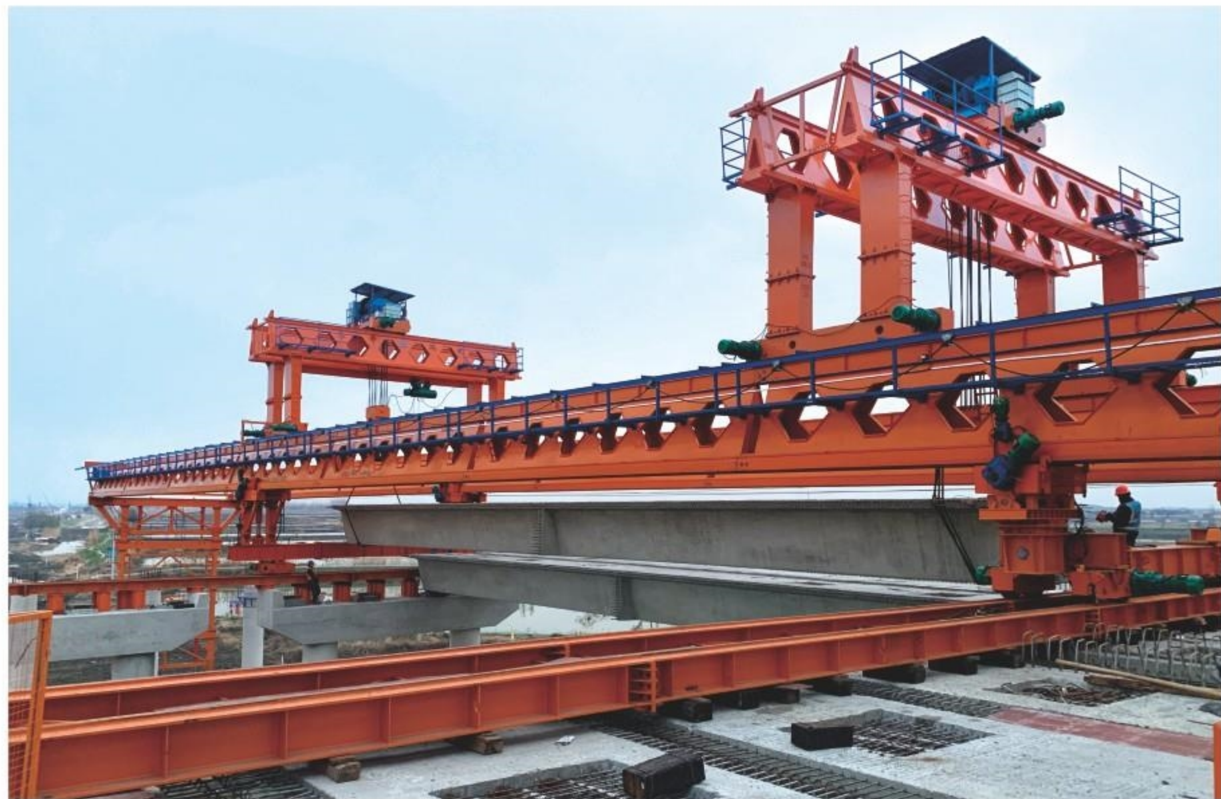
● 一体化架桥机安装小箱梁
