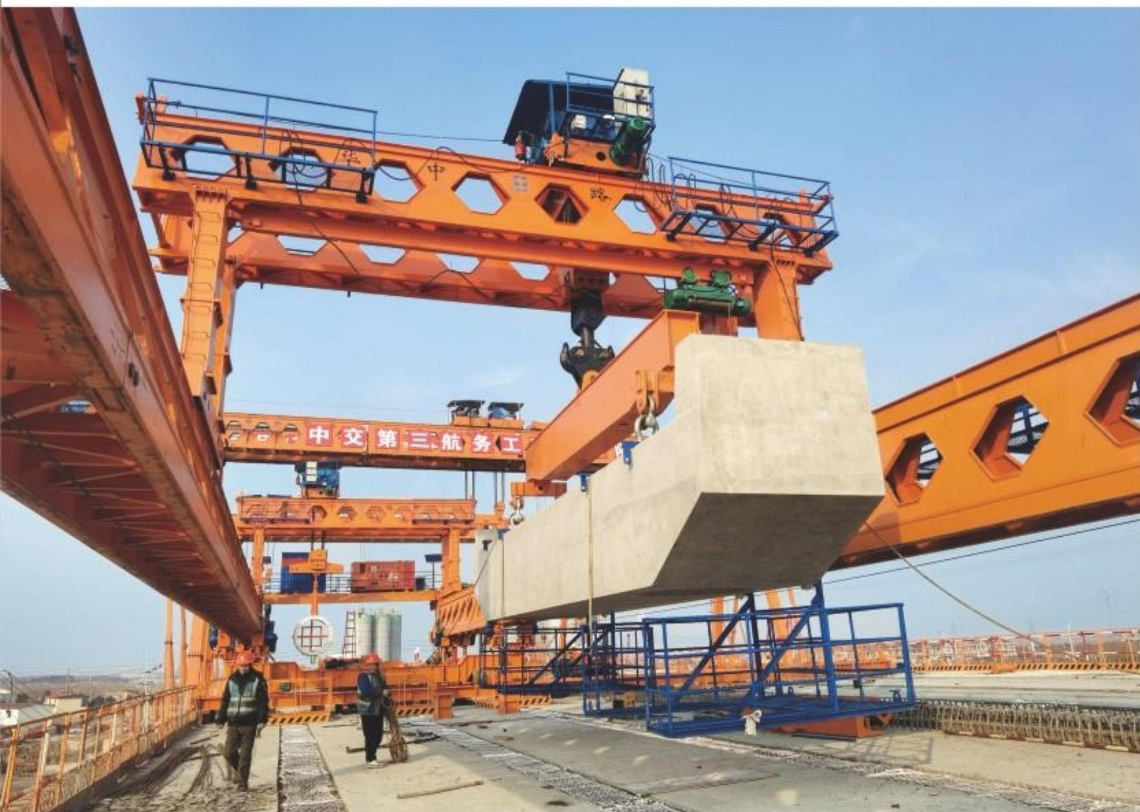
一体化架桥机天车 吊装预制盖梁前行
