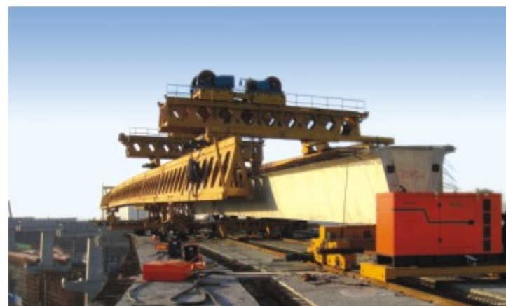
◆ 箱梁在S弯道上的运输及架设
