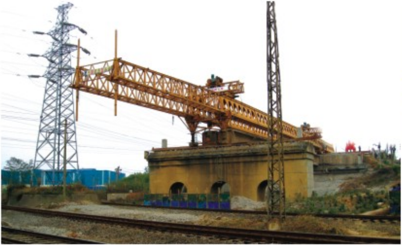
◆ 中铁七局承包的武汉青化路跨线架桥机反向作业拆除老桥。51米T梁。
