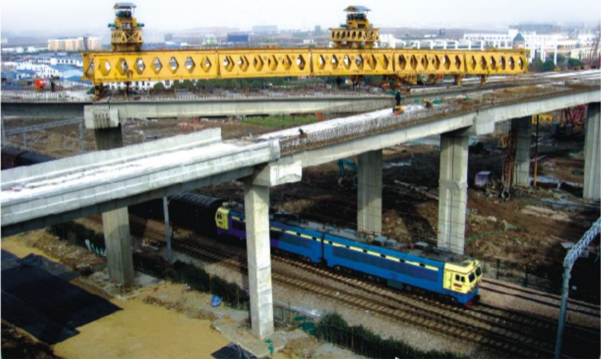
◆ 中铁一局承包的上海嘉闵高架A9跨线桥，跨沪昆线，35米箱梁。
