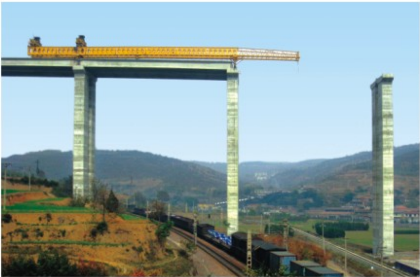
◆ 中铁七局承包的阳翼高速三标跨线桥，跨侯月铁路，50米T梁，桥墩最高68米。
