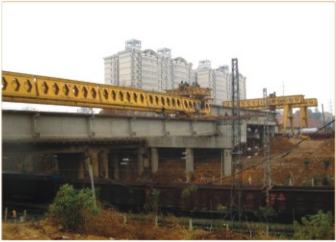
◆ 中铁七局武汉公司承包的武汉市政工程跨线桥，跨京九线，50米T梁。
