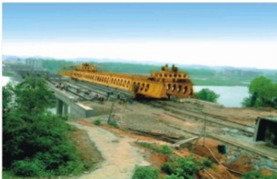
湖南路桥承建的106国道攸县沱水河大桥
