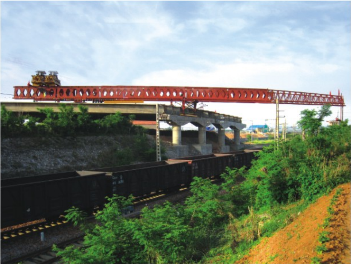
◆ 郑州中原铁路工程公司承包的晋城外环跨线桥，跨晋焦线，40箱梁，35度斜角。
