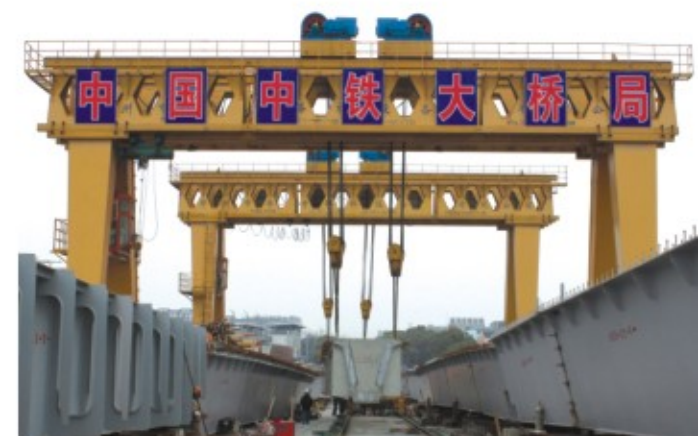
◆ 钢砼叠合梁的现场制作及叠合
