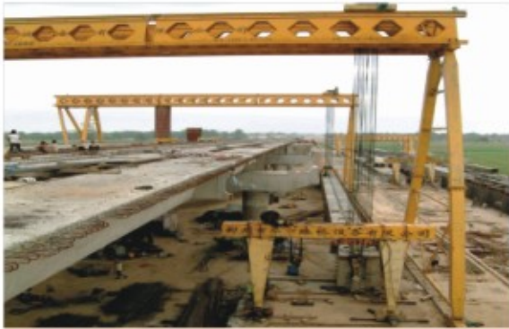
中铁十局二公司关中公路环线渭河特大桥A标
