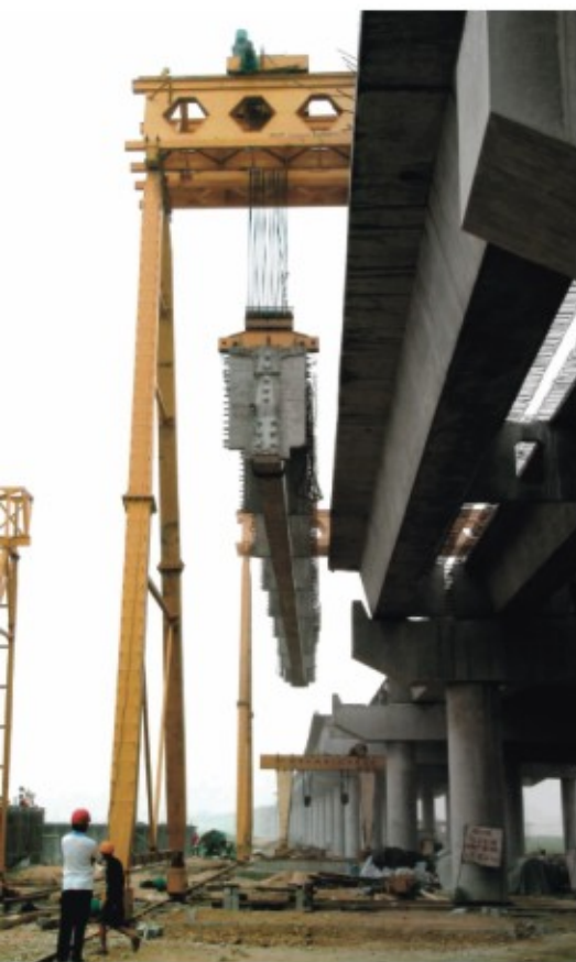
◆ Mg型门式起重机正在给轮轨式运梁车装梁
