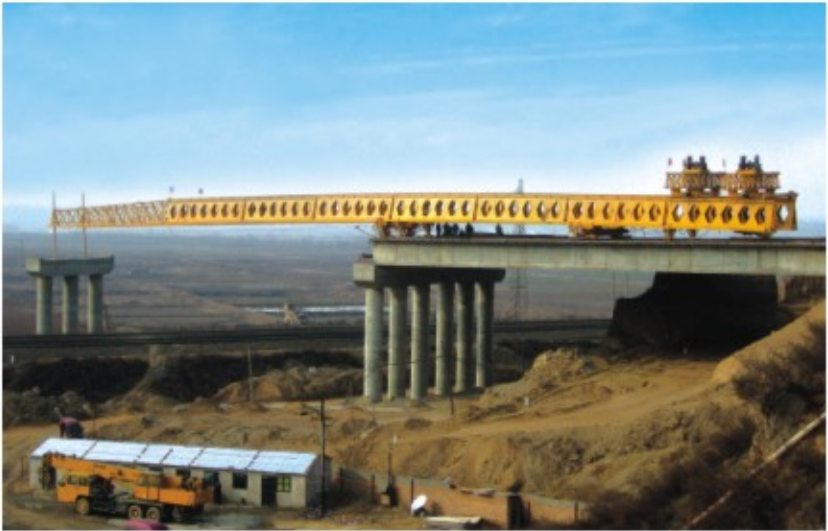
◆ 中铁十三局承包的侯翼高速跨线桥，跨侯月铁路。50米T梁。
