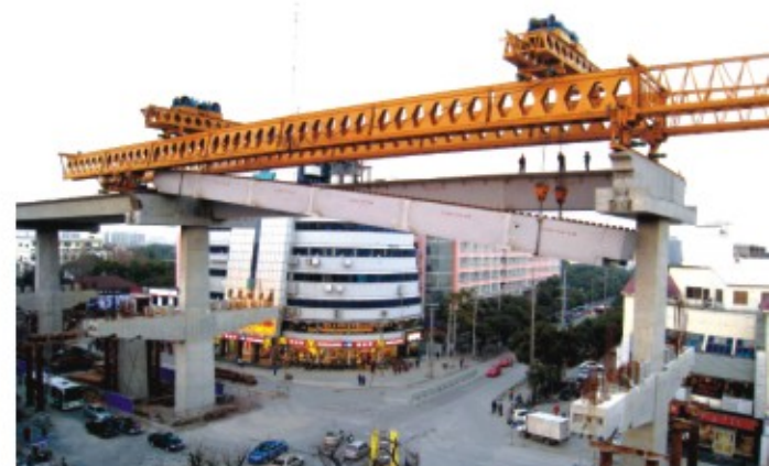
◆ HJQ300-50架桥机正在将51m钢砼叠合梁高低吊方式落梁到下层轻轨盖梁上
