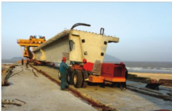
江西省路桥集团公司承建的广东省南澳跨海大桥工程
