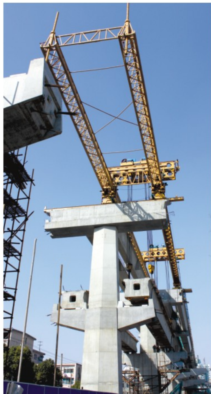
◆ 箱梁在S弯道上的运输及架设
