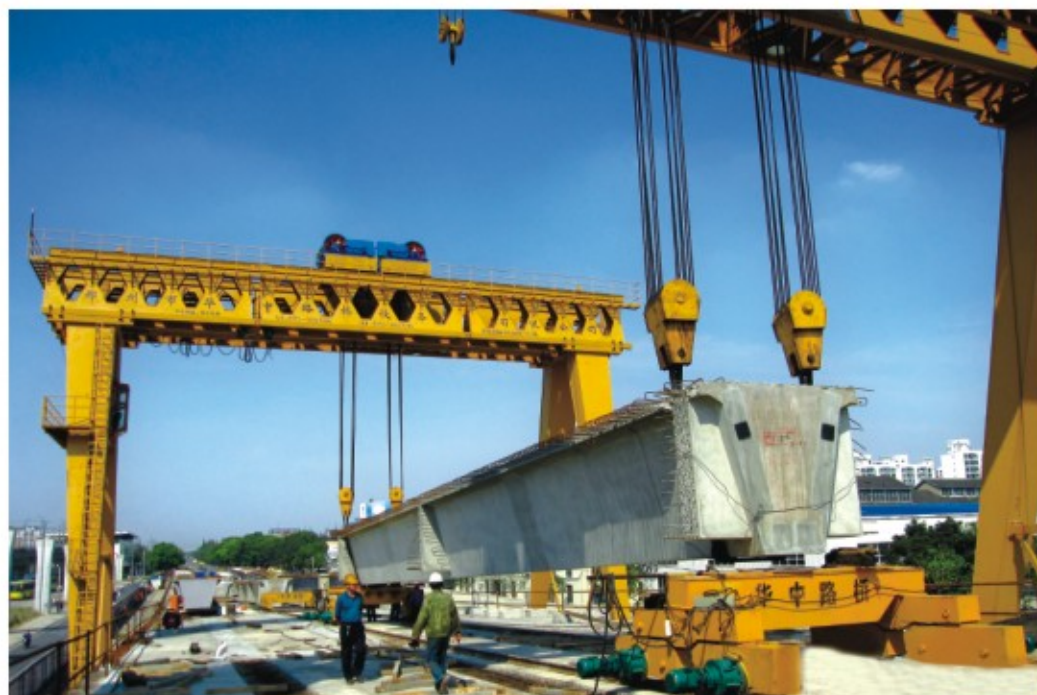
◆ Mg型门式起重机正在给轮轨式运梁车装梁
